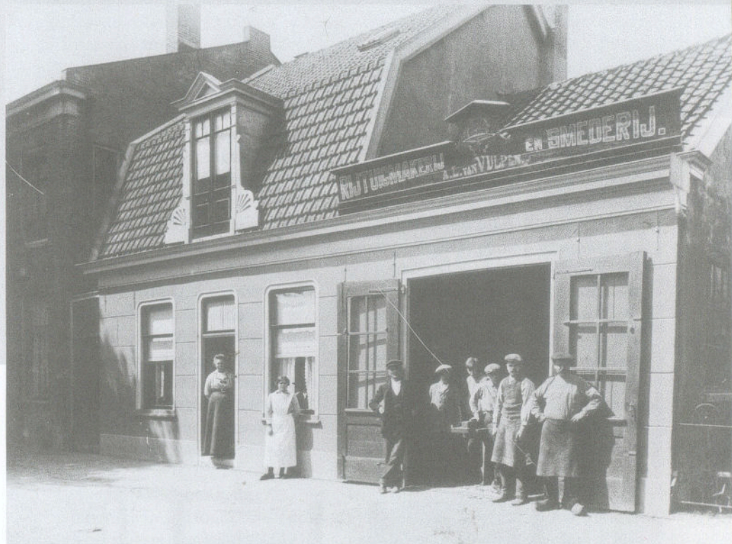
Afb. 1: Hooftstraat nrs. 279 en 281: de oude smederij van A.L. van Vulpen. In de deuropening Maartje Sprey; geheel rechts staat Arie de Wit, de opvolger van Van Vulpen (foto, coll. J.A. Henry).
