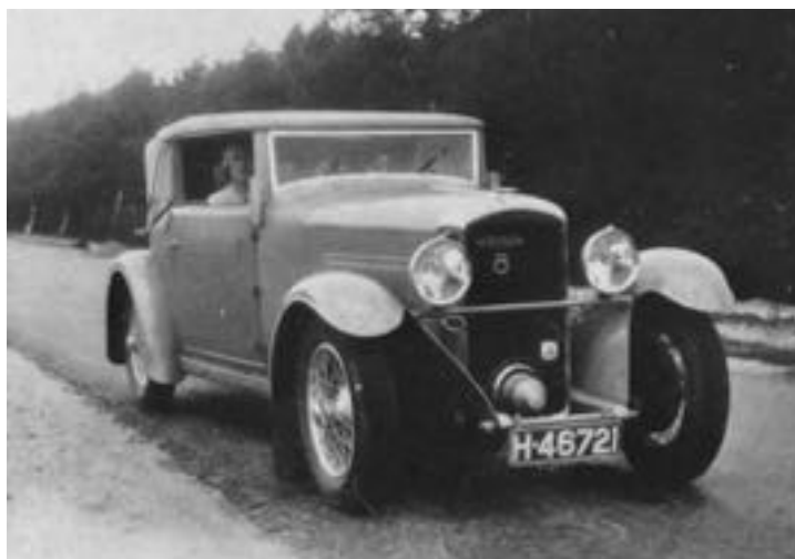
De Amilcar achtcilinder van Leen van der Vlugt, met mevrouw Van der Vlugt achter het stuur (zoals bij de meeste Franse luxe-auto's was het stuurwiel rechts). De smalle hoge radiator hoorde bij het ‘rijdend chassis’ zoals dat werd geleverd door de Amilcar-fabriek. De strak gelijkende hoekige carrosserie, zonder treeplanken, was gebouwd op basis van aanwijzingen van de architect.
